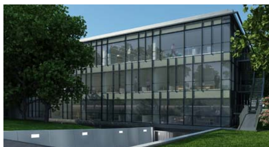
Het paviljoen heeft een betonprefabconstructie met glasgevels
